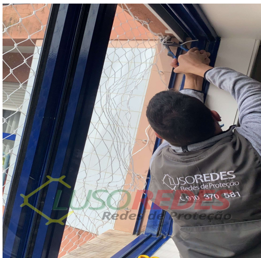
Imagens " fechamento dos Ganchos sendo no local"
