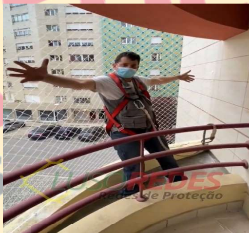
Imagens " Testes a fixação e resistência empurrando-as com as mãos e o peso do próprio corpo"
