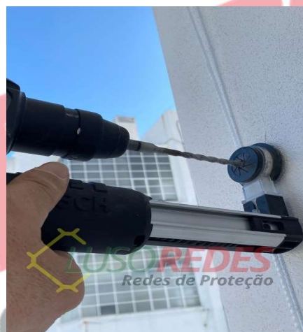
Imagens " execução dos furos tradicionais"
